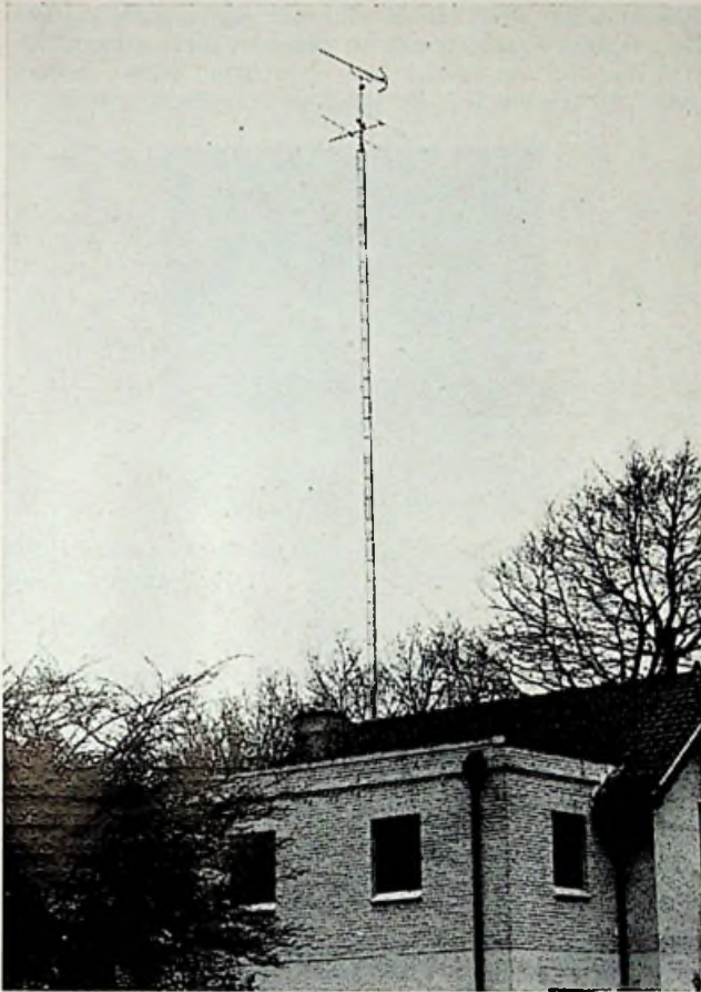
Afb. 2 - Voorbeeld van een pylonenmast (fabr. Rovasan), welke ruimschoots boven de omringende bomen uitsteekt, wat een waarborg is voor betere ontvangresultaten (foto Rovasan Hilversum).
